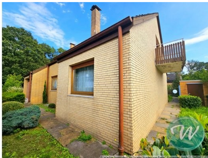
Nordwestseite mit Südwestgiebel
