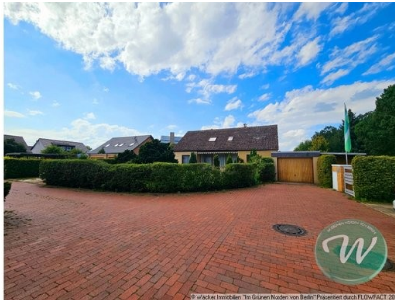
Blick von der Anliegerstraße auf die Liegenschaft
