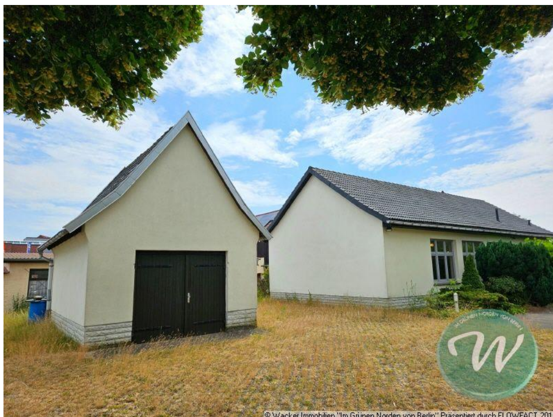
Haupt- und Nebengebäude
