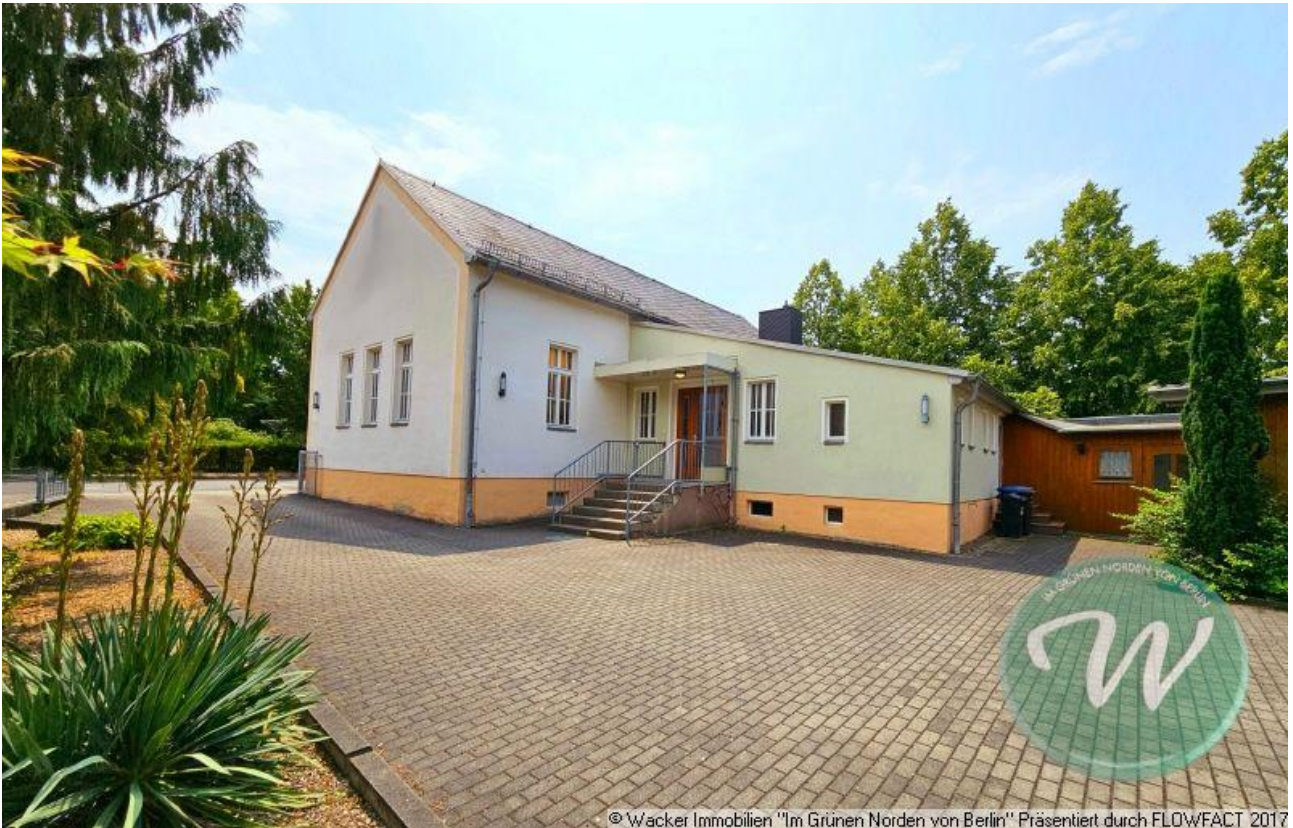
seitlicher Blick vom Hof auf das Gebäude
