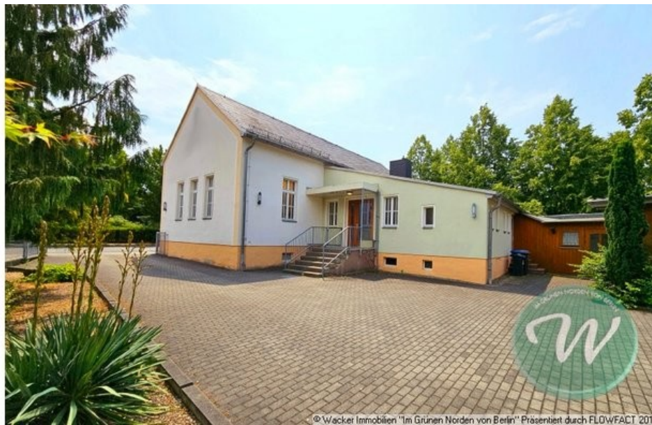
seitlicher Blick vom Hof auf das Gebäude
