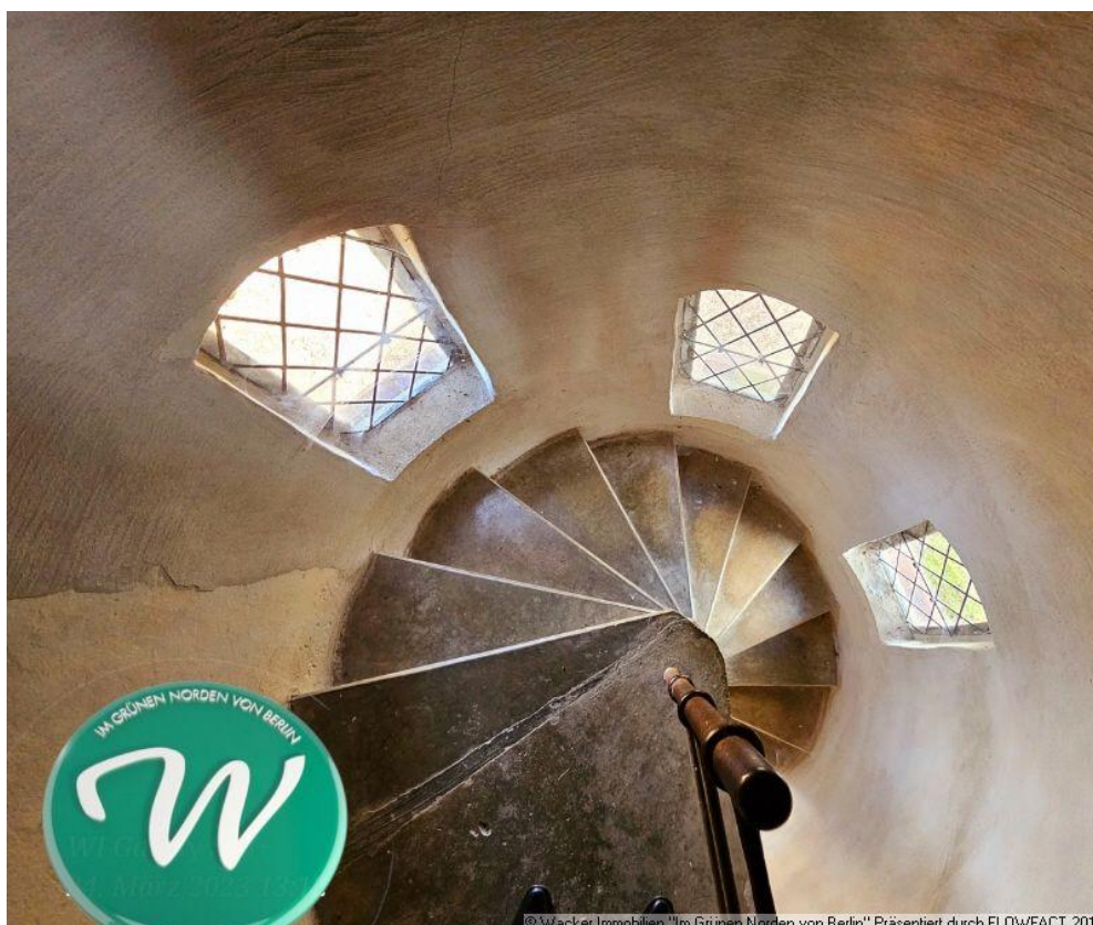
Wendeltreppe im Turm
