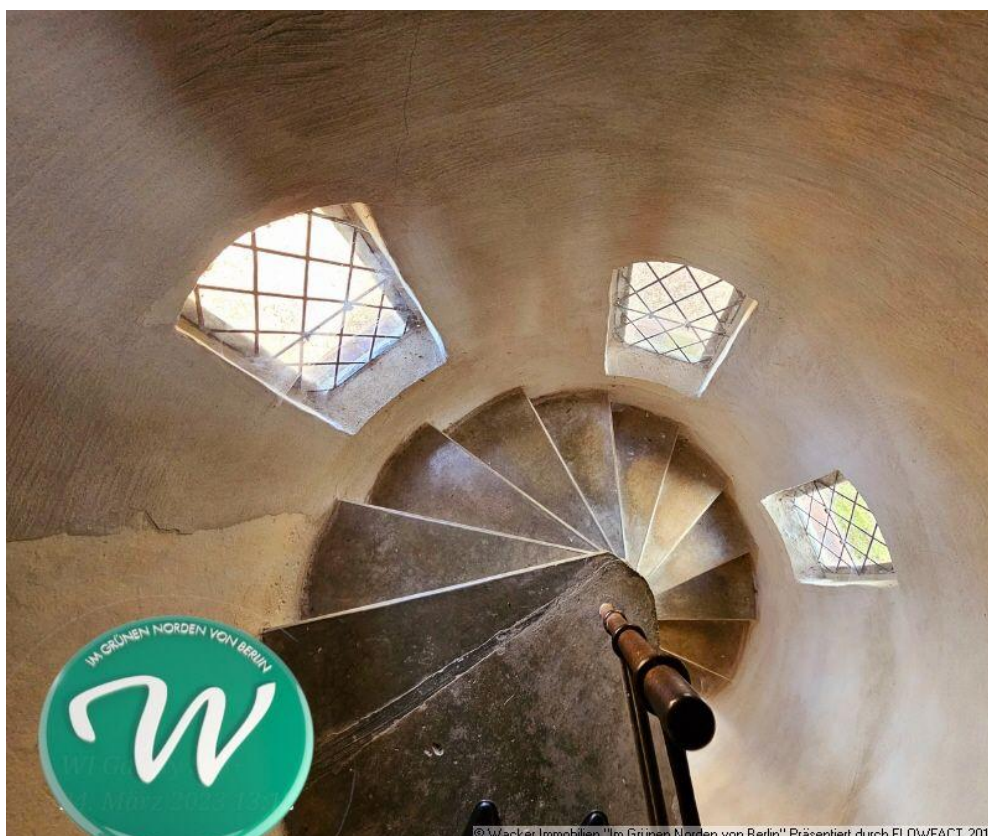
Wendeltreppe im Turm
