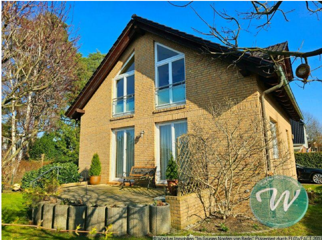
Außenansicht mit Blick auf die Terrasse
