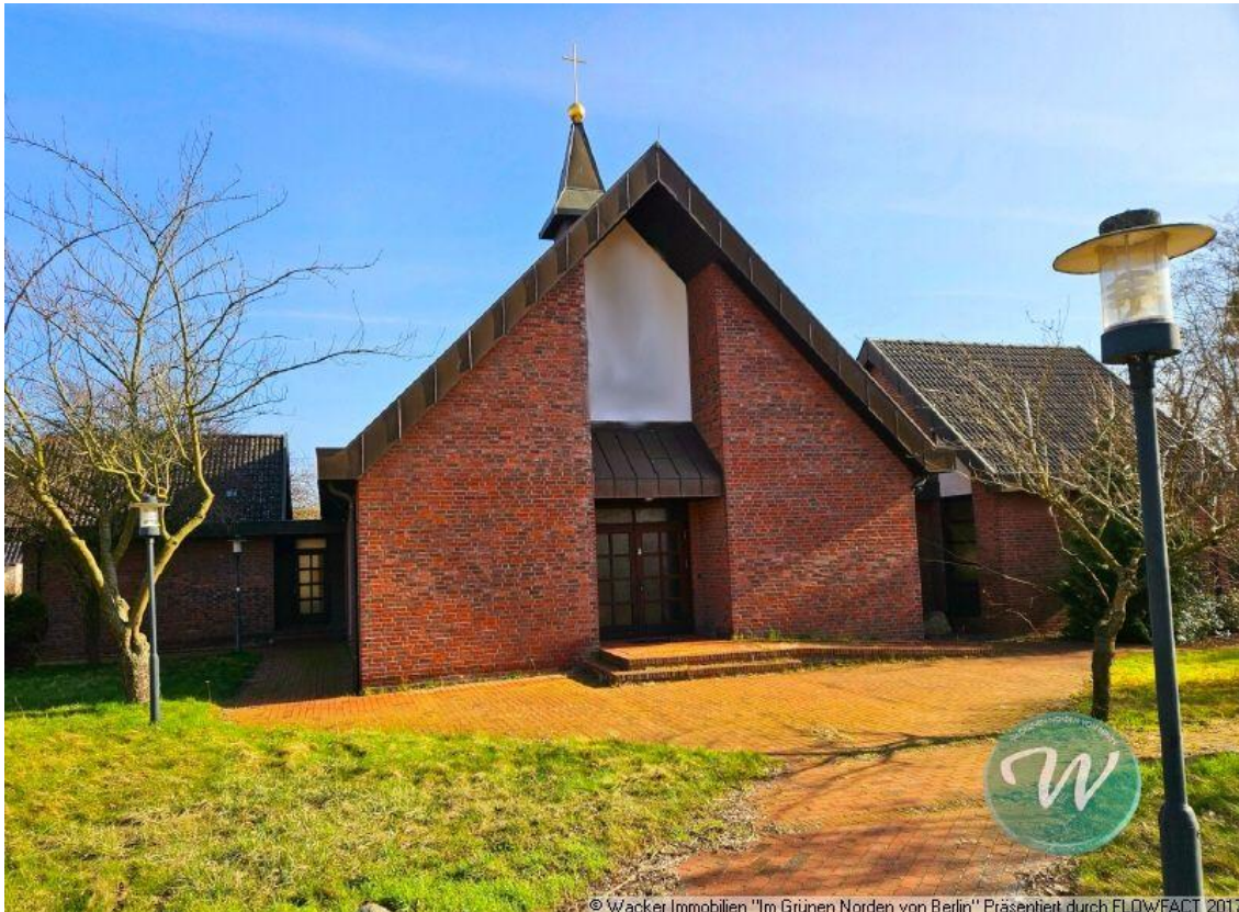
Blick auf den Haupteingang der Liegenschaft
