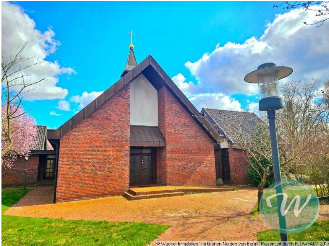
Blick auf den Haupteingang der Liegenschaft
