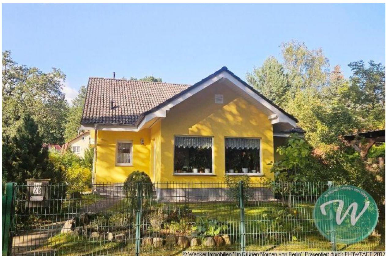
straßenseitiger Blick auf die Liegenschaft
