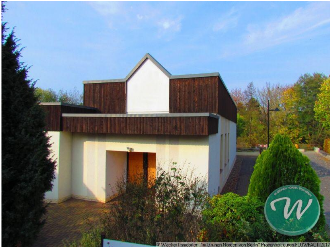
Blick auf die Liegenschaft
