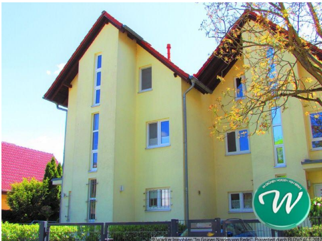
Straßenansicht der Liegenschaft
